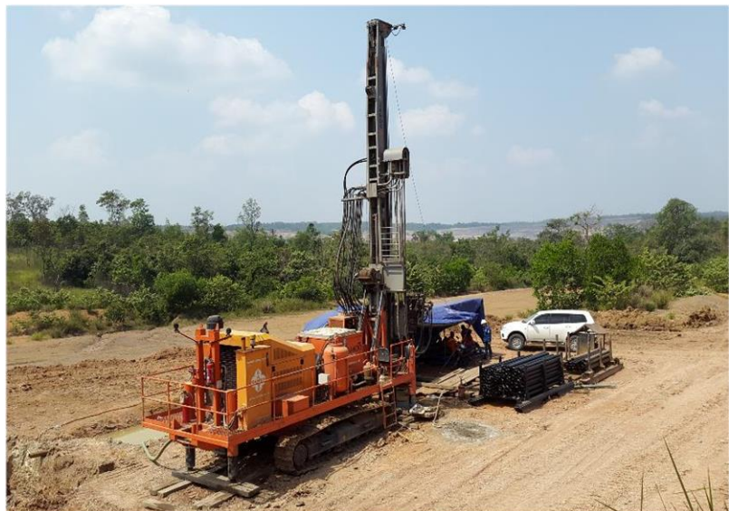
Rig Site at TE-008C
